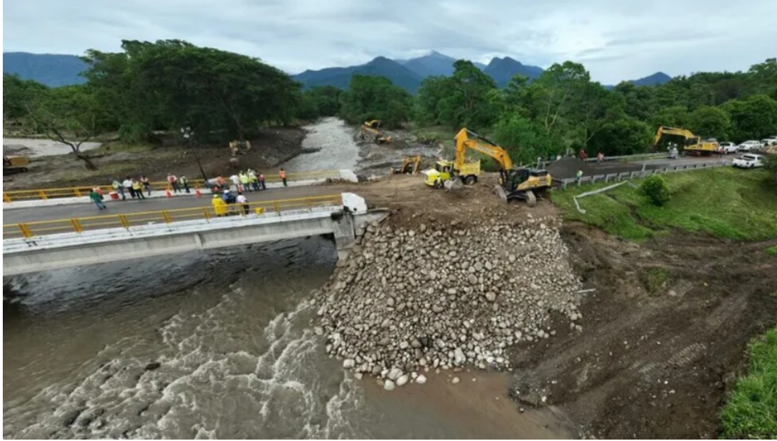
Figura 1a. Reconstrucción del puente sobre el Río Novillero, autopista Mapastepec-Tapachula. Participación de CMIC y SICT (2025).
